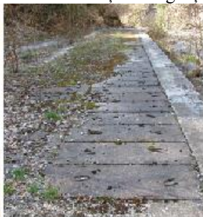
Fig. 4. Desnisipator
