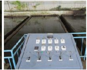
Fig. 8. Stația de filtrare, stratul filtrant și pupitrul de comandă
