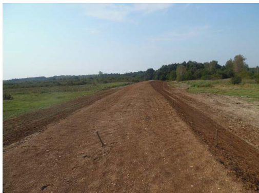
Fig.1 Dig din pământ argilos compactat
