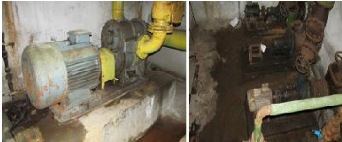
Fig. 9. Camera de pompare (foto stânga) și sistemul de țevi destinat transportului apei potabile către rezervoare și oraș (foto dreapta)
